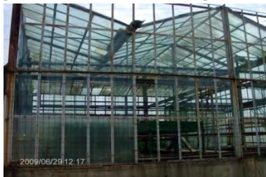
Figura 30. Casa de vegetație
