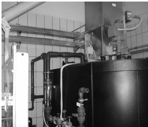
Figura 22. Dispozitivul Alldos pentru prepararea si dozarea solutiei de pudra de carbune activ din cadrul Complexului de tratare a apei Chirita Iasi
